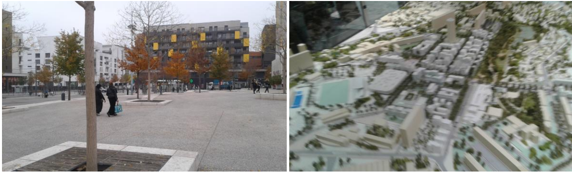
Figura 4 – Proyecto de renovación urbana del Grand-ensemble La Duchère – Gran Lyon – Fotos de la Plaza Abbé Pierre (centro local) y modelo del proyecto
