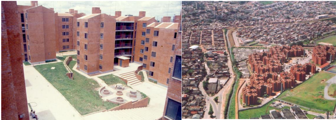
Figura 1 – Complexo COPROMO – Osasco - SP, concebido e construído de forma participativa pela USINA – Densidade 630 hab/ha
