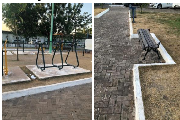
Figuras 9 e 10 – Mobiliários danificados
