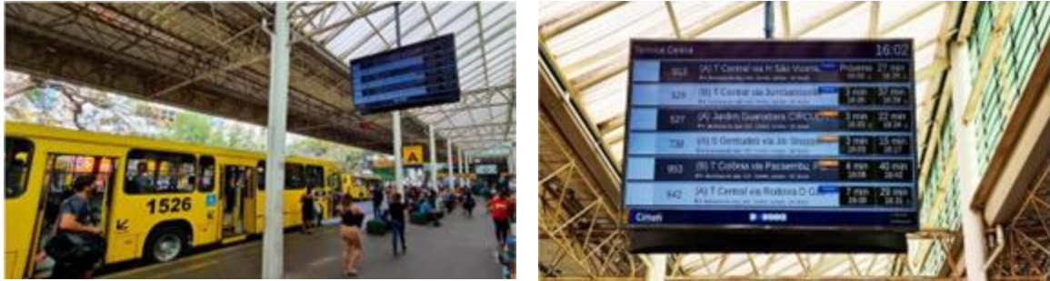
Figura 11: Fotos dos painéis de TV instalados nos terminais de ônibus de Jundiáí
