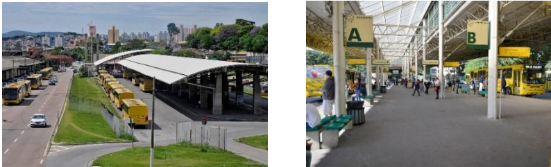
Figura 10: Fotos dos terminais de ônibus de Jundiaí
