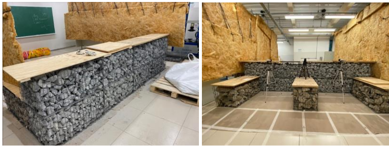
Figura 4 - Elementos de gabiões já finalizados – parte frontal e posterior.
