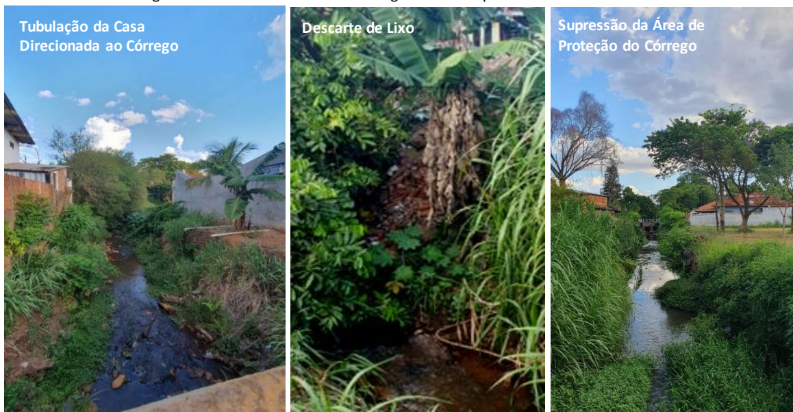
Figura 9 – Problemas Trecho do Córrego Viradouro próximo a Área Central
