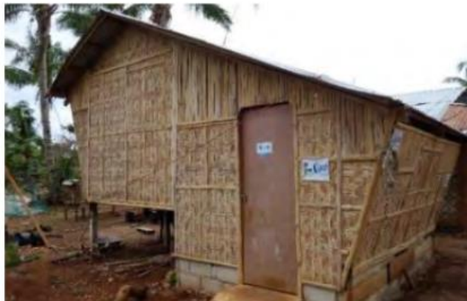
Figura 11 - Abrigos construídos Sungko, Filipinas (2013).
