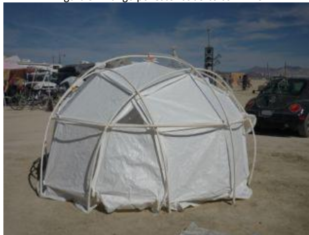
Figura 5 - Abrigo poliéster coberto com PVC
