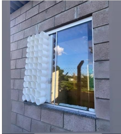
Figura 11 – Equipamento Eco Cooler instalado na janela da casa modelo
