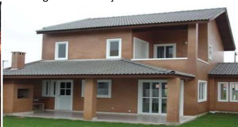
Figura 2 - Execução da técnica
