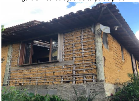
Figura 3 – Construção de taipa de pilão
