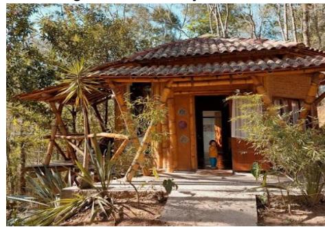
Figura 17 – Construção com base de concreto
