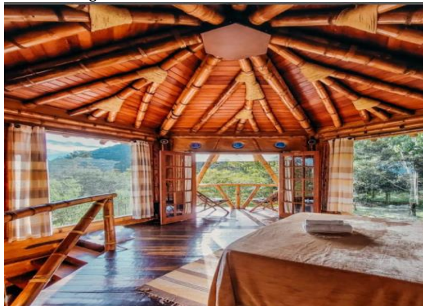
Figura 18 – Estrutura de bambu
