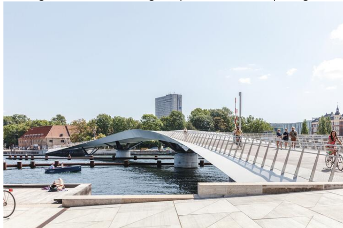
Figura 6 – Ponte Lille Langebro para ciclistas em Copenhague
