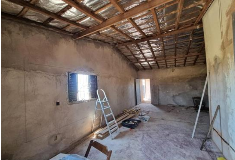
Figura 6 – Edificação em reforma com ampliações sendo realizadas.
