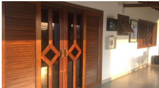
Figura 8 – Fachada principal após reforma.
