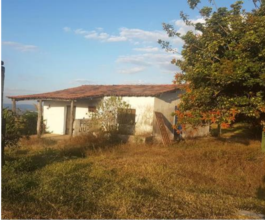
Figura 3 – Edificação existente, antes da reforma
