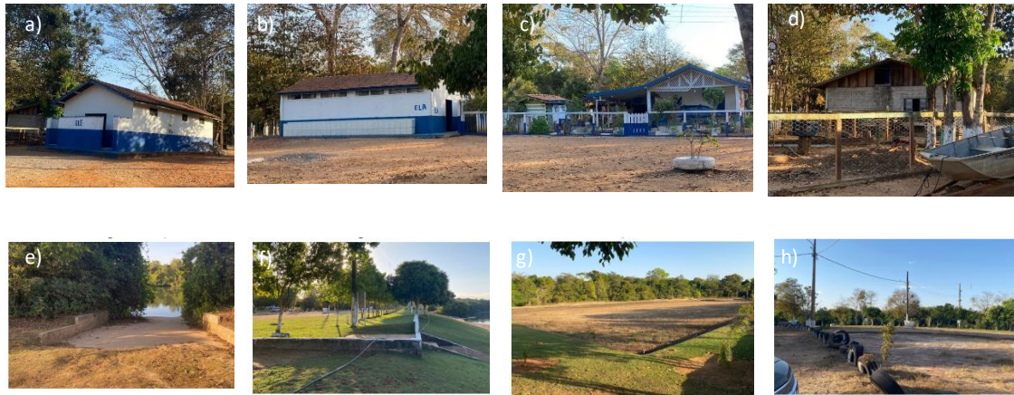
Figura 5 -Levantamento Fotográfico (a) Banheiro masculino, banheiro feminino, (b), (c) casa dos funcionários, (d) casa de apoio, (e) rampa para as embarcações, (f) escada, (g) piscina desativada e (g) área do palco
