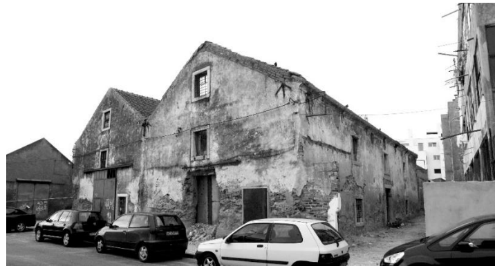
Figura 3: Ruína do Armazém do Barreiro.
