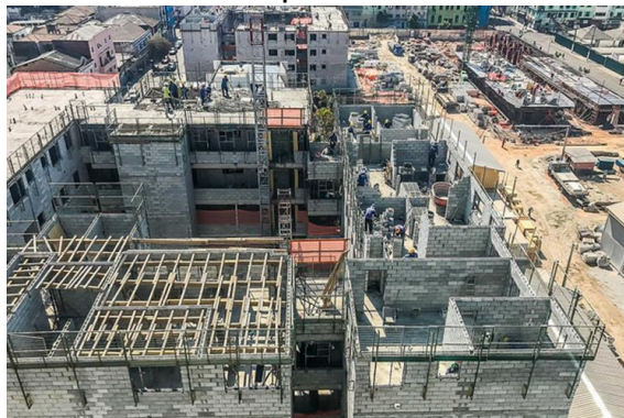
Figura 5 – Torre residencial do Complexo Júlio Prestes em fase de construção.
