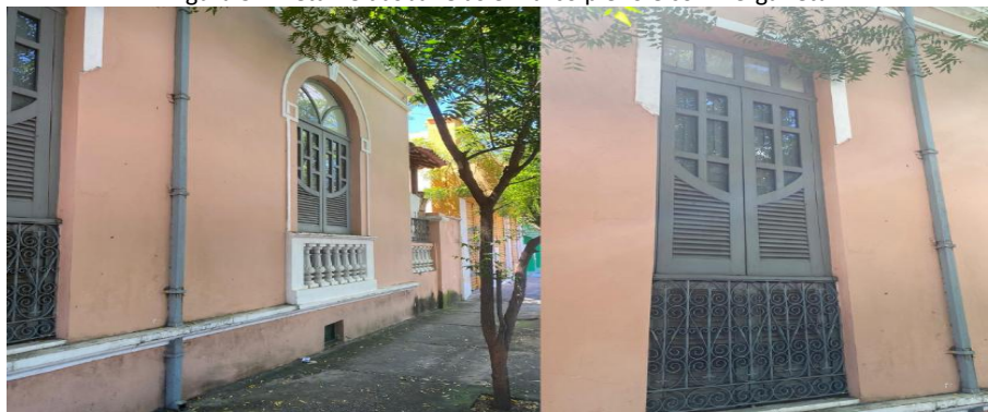
Figura 3 – Detalhe das Janelas em arco pleno e com verga reta
