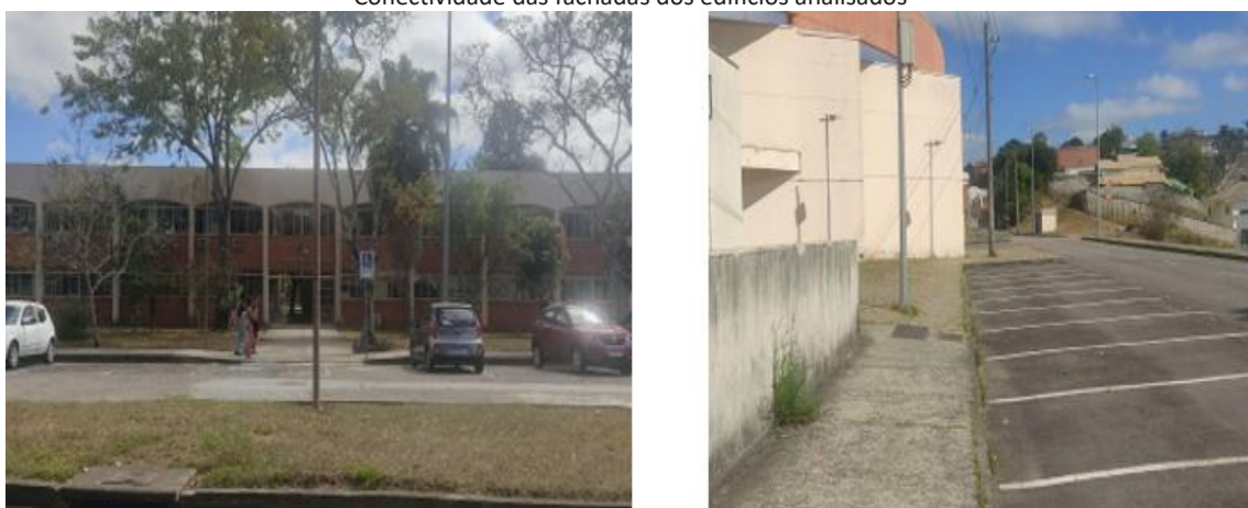
Figuras 5 e 6: Faculdade de Engenharia e Instituto de Artes e Design, respectivamente. Conectividade das fachadas dos edifícios analisados
