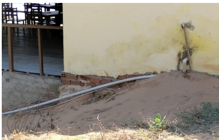
Figura 2: Ligações clandestinas de esgoto.
