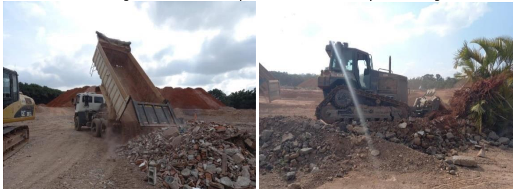
Figura 3. Reuso dos RCC para aterro hidráulico do pavimento rígido.
