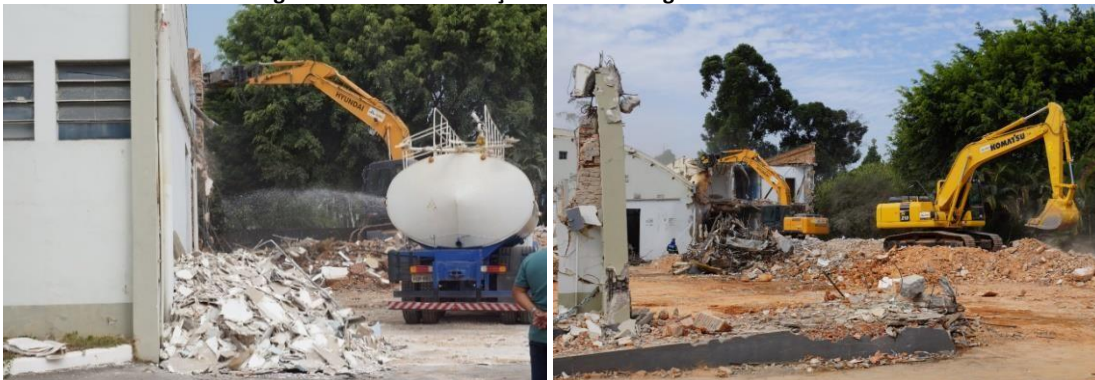
Figura 1. Fase de demolição do Centro Logístico da Aeronáutica
