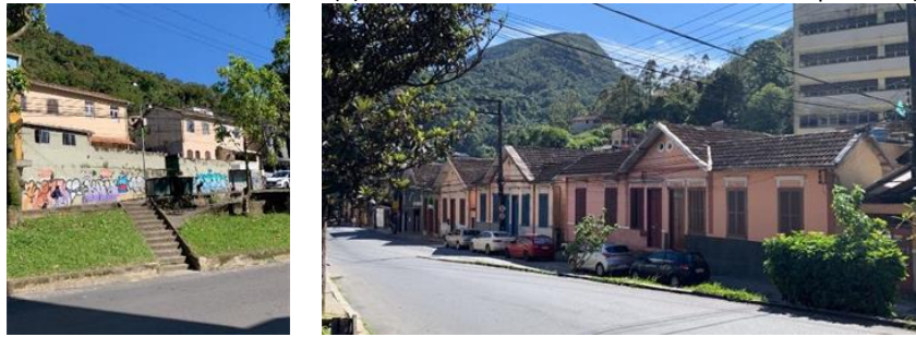
Figura 7 - Dois edifícios da Cometa (a) e casas remanescentes de uma das Vilas Operárias (b)
