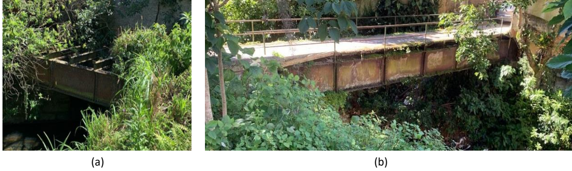
Figura 12 - Resquícios das pontes sobre o Rio Palatino: ponte 1 (a) e ponte 2 (b)
