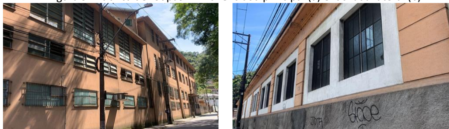
Figura 9 - Fábrica de roupas Ikinha: entrada principal (a) e fachada lateral (b)
