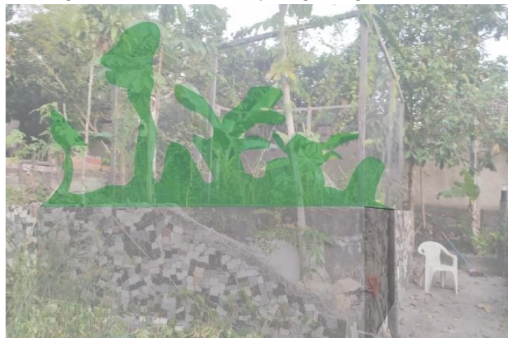
Figura 3 – Sistema construído para águas negras.
