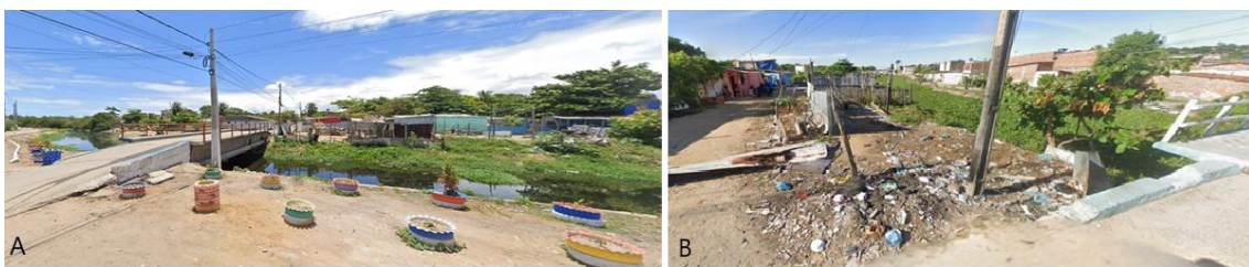
Figura 7. Local escolhido para instalação da ECObarreira, na Av. Beira Rio em Olinda- PE A e Resíduos descartados diretamente no solo, às margens do rio Beberibe B
