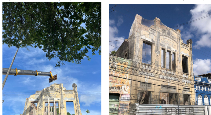
Figura 9 – Conjunto: a) Demolição parcial do “A Fonseca” e b) Reconstrução da parte demolida.
