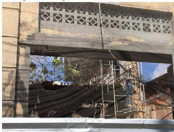
Figura 13 – Imagem do estado interno do edifício.
