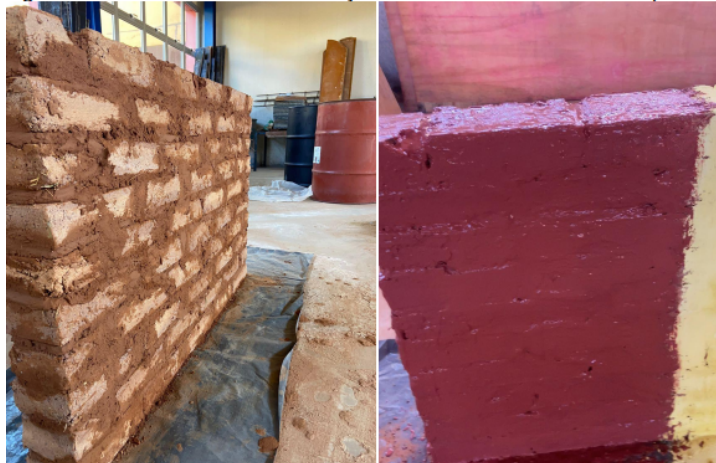
Figura 8 – Parede construída com tijolos de adobe e acabamento aplicado.
