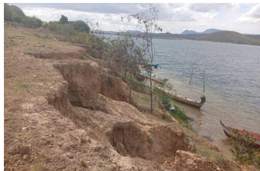
Figura 6 – Erosão no rio São Francisco
